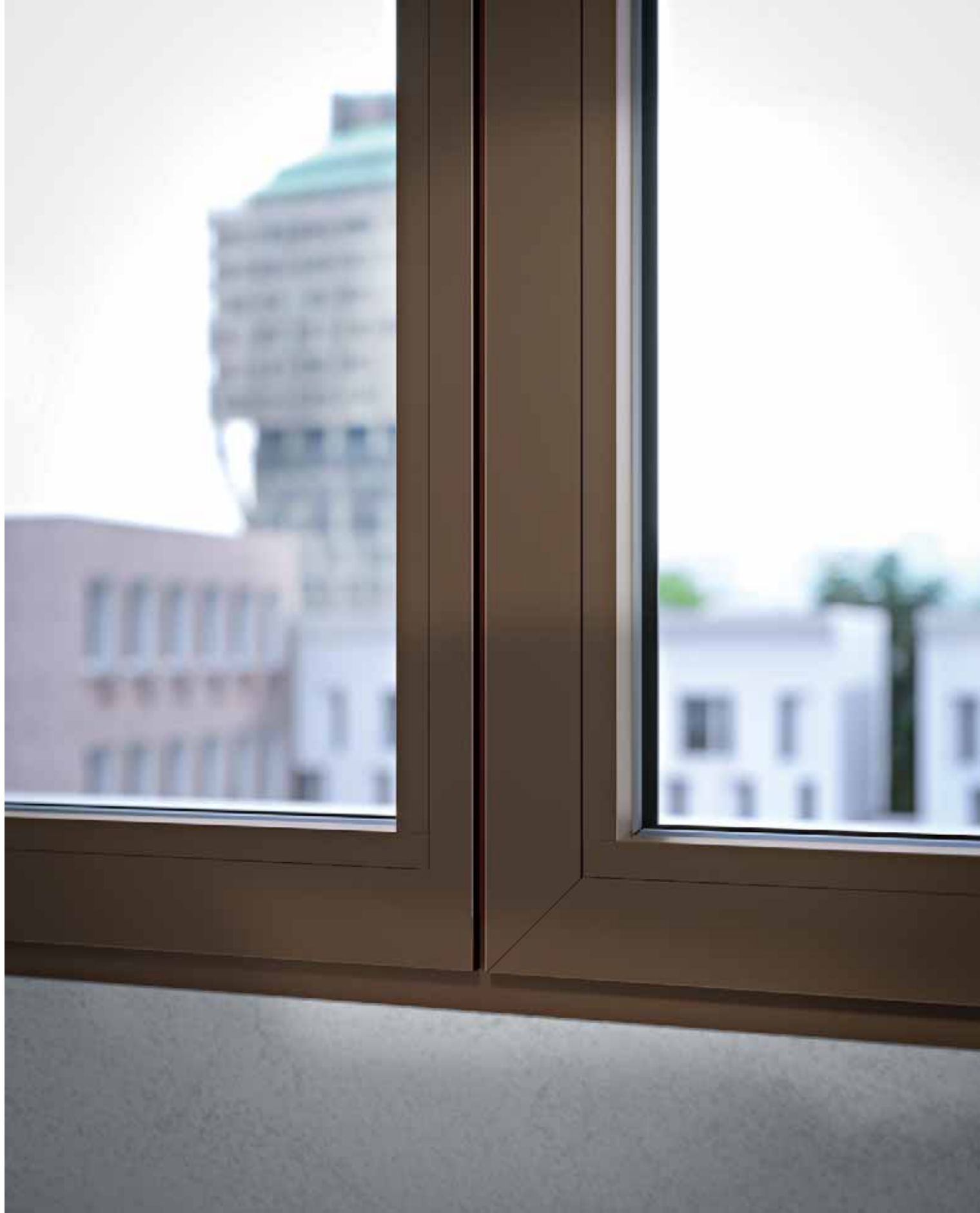
Particolare nodo centrale ridotto, vista interna
